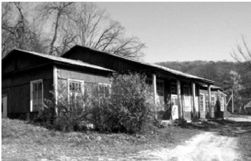
Главный лабораторный корпус Горнотаёжной станции в 1930–1950-х гг. Фото В. Богатова, октябрь 2011 г.
