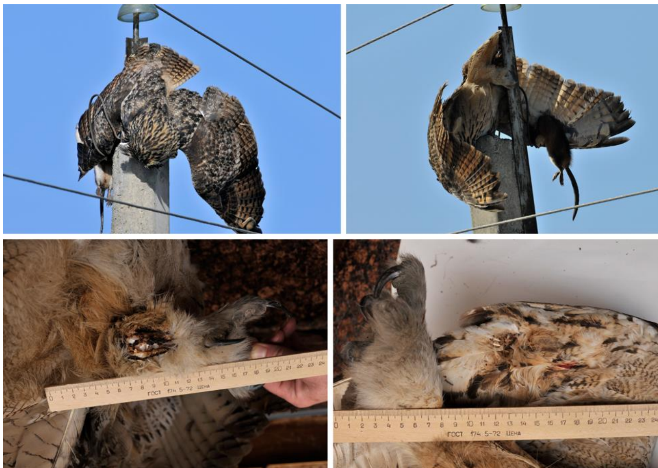
Рис. 22. Филин Vubo bubo с пойманной ондатрой Ondatra zibethica , погибший на линии ЛЭП от удара током. На нижних снимках показаны ожоги на ноге и крыле. Окрестности Уссурийска, 12 февраля 2012. Фото Д.В.Коробова
