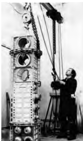
У истоков модульной технологии. Сборка АНПА «Л-1», 1979 г. Фото с сайта ИПМТ
