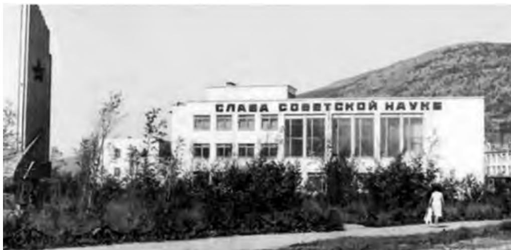
Комплекс зданий СВКНИИ. Фото 1980-х гг. из открытых источников
