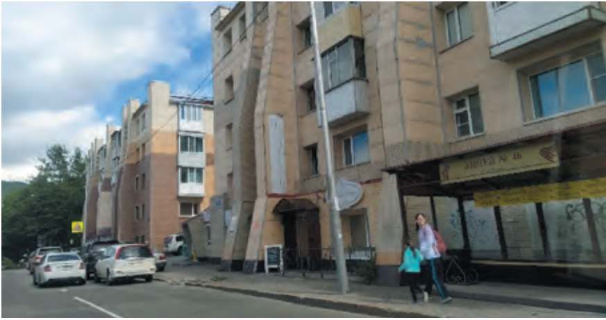
Вид жилых домов в Петропавловске-Камчатском после их сейсмоукрепления, 2022 г. Фото В. Богатова
