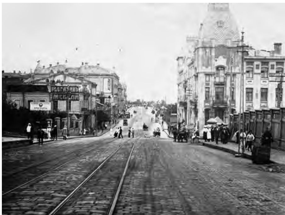
Владивосток, ул. Ленинская, 50 (здание справа). Фото из открытых источников
