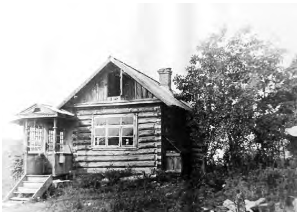
Одно из первых зданий на Горнотаежной станции постройки 1929 г. Фотоархив ГТС
