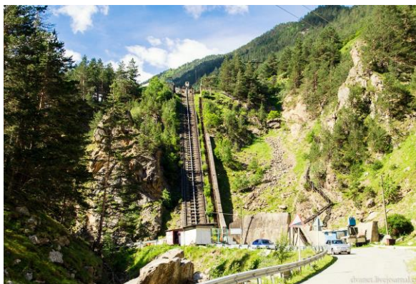
Рис. 10Прил.1. Адыл-Су. Подъёмник.
