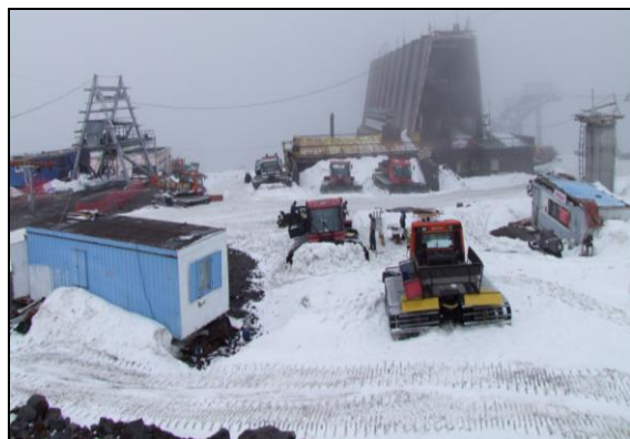
Рис. 11 Прил.1. Комплекс канатных дорог на горе Эльбрус (верхняя станция).
