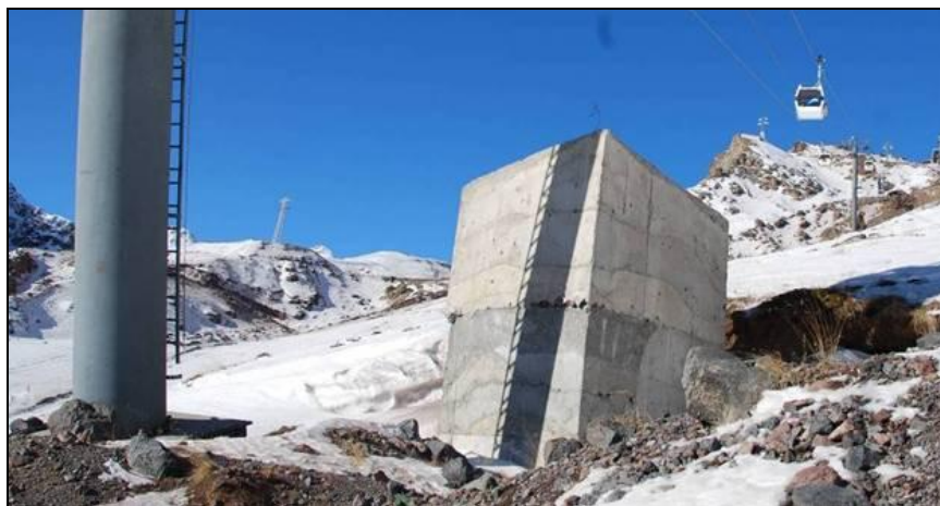
Рис. 13-Прил.1. Противолавинные сооружения. Фото Кюль Е. В., 2017. Fig. 13-Att.1. Anti-avalanche structures. Photo Kyul E. V., 2017.
