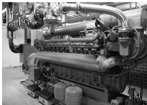
Рис. 20.8. Модуль КГУ мощностью 1,2–1,5 МВт
