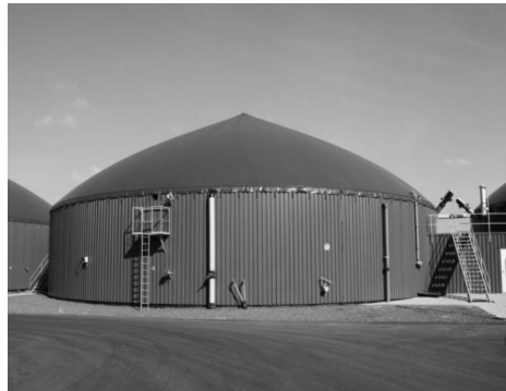
Рис. 20.4. Метантэнк с газгольдером на крыше
