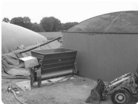
Рис. 20.3. Внешний вид метантэнка с загрузчиком
