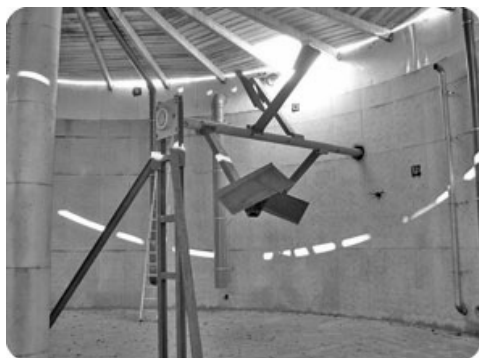
Рис. 20.5. Внутренний вид метантенка с мешалкой
